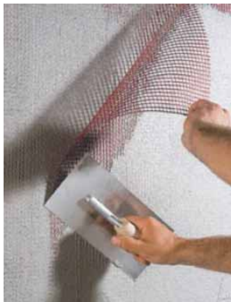
Bild 8: Armierungsputz mit Gewebeeinlage
