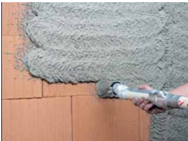
Bild 14: Auftrag des Unterputzes auf Planziegelmauerwerk
