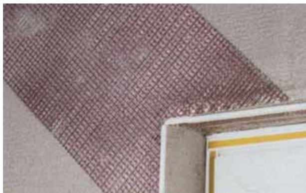
Bild 7: Armierungspfeil an Öffnungsecken
